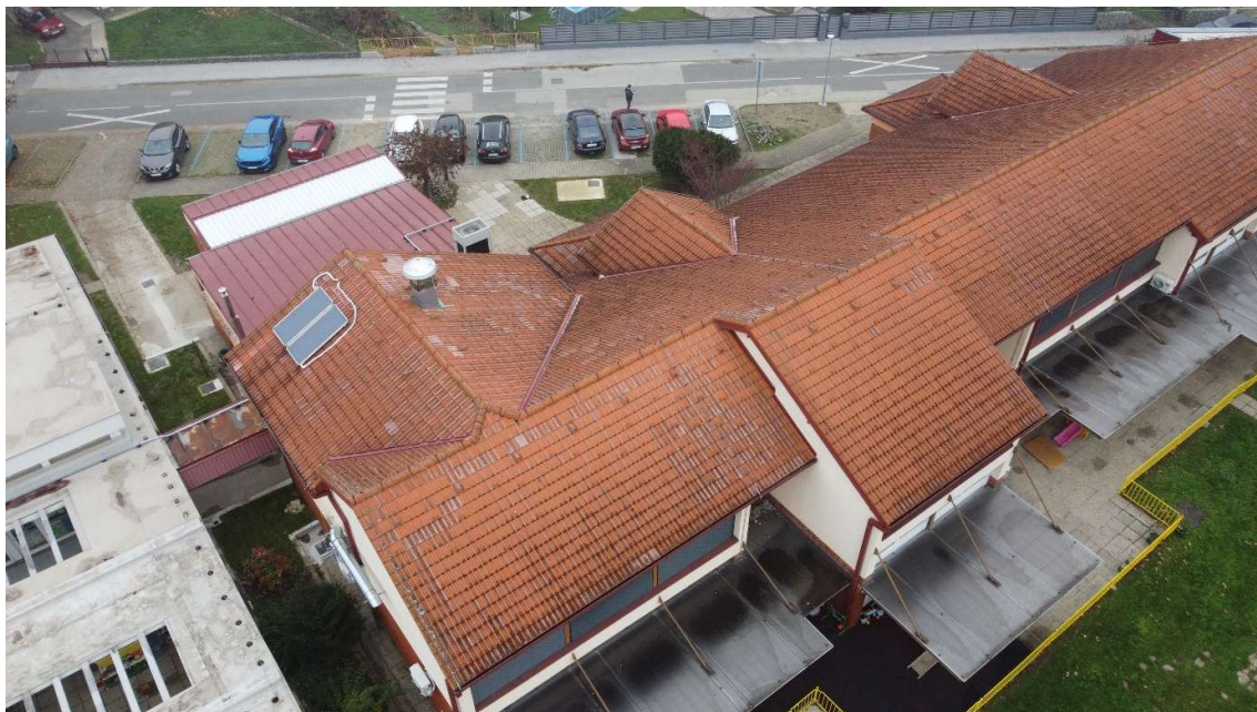
Slika : Krov građevine na koji dolazi elektrana
