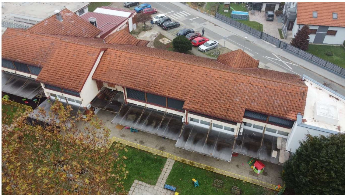
Slika : Krov građevine na koji dolazi elektrana
