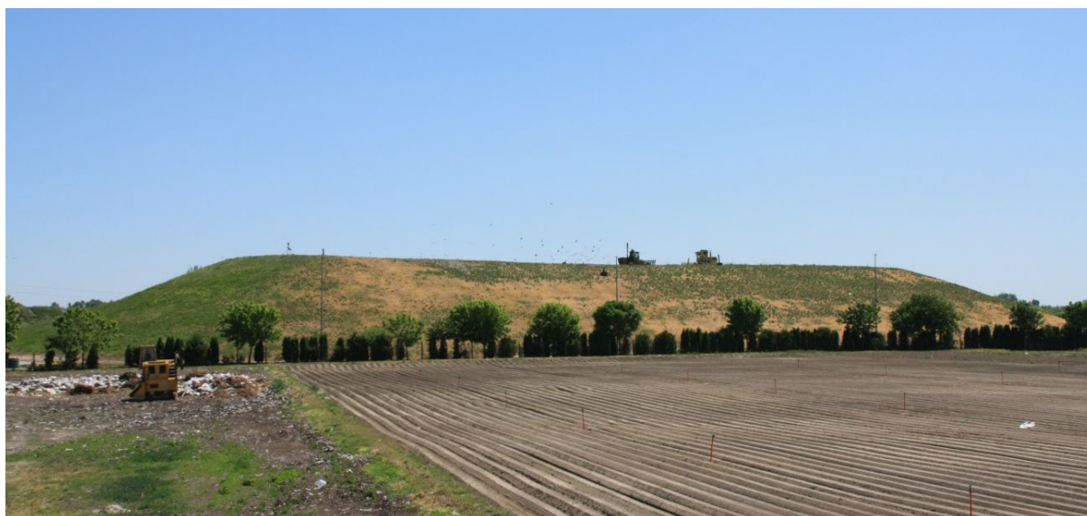
Odlagalište neopasnog otpada Totovec (foto: GKP Čakom d.o.o.)
